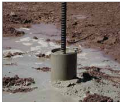
Encoframientos con micropilotes instalados con refuerzo de barras totalmente roscadas de 75 ksi
